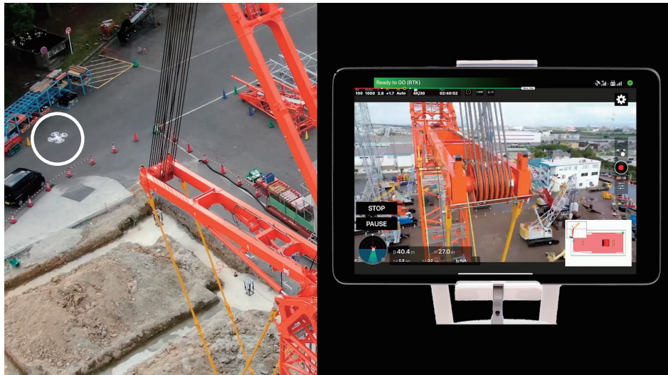
図2 約2mの距離を維持しながら自動飛行するドローンと、実際のモニタ画像 Drone flying automatically while maintaining of about 2 meters and its actual monitor image
