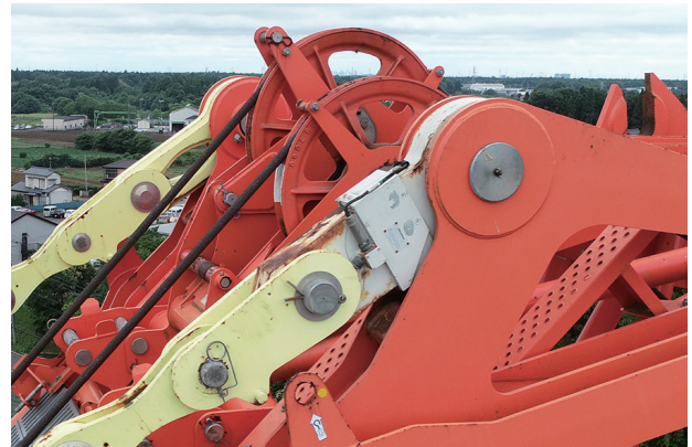
図4 実際の点検画像：接続ピンや割りピンの挿入状態 Actual inspection images : Status of joint pins and split pins inserted
