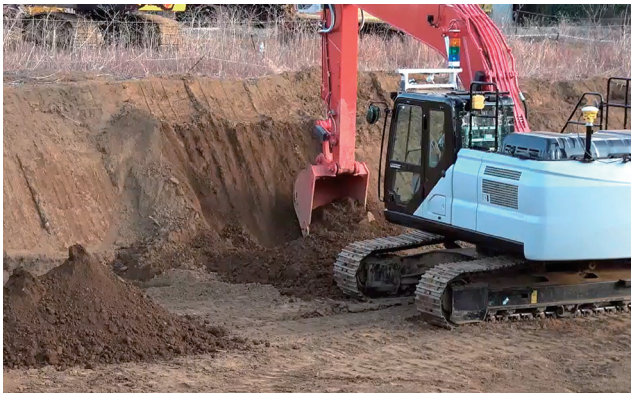
図9 法面整形試験 Slope leveling tests
