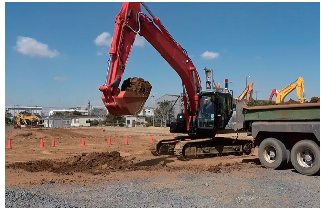
図8 掘削積込み試験 Loading dump trucks tests
