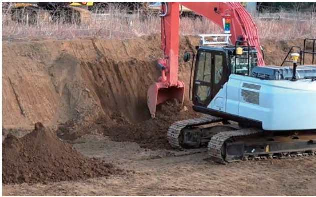
図9 法面整形試験 Slope leveling tests
