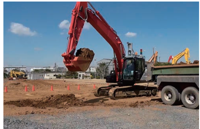
図8 掘削積込み試験 Loading dump trucks tests
