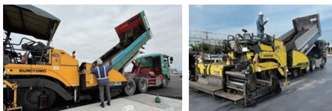
図1 現状のダンプトラック運転手への誘導指示 Current guidance instructions to dump truck drivers
