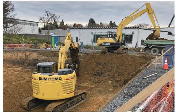
図4 実証試験現場例 Example of demonstration test site
