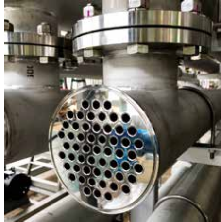
図2 熱交換器 Shell & tube heat exchanger
