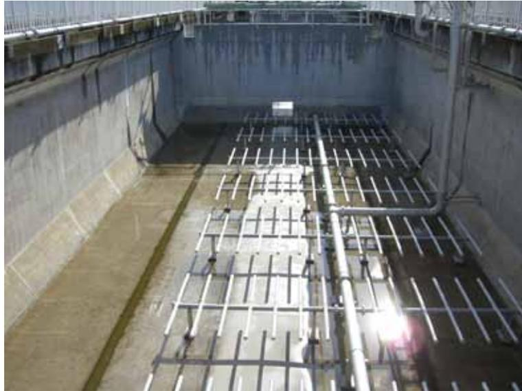
メンブレンパイプ式超微細気泡散気装置
