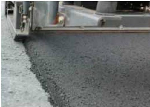
図6 サイドプレートによる端部の成形
