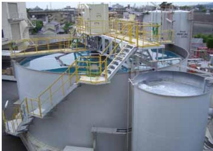
図1 スミシックナー®納入事例(手前が反応槽、その奥がφ15mスミシックナー®)
