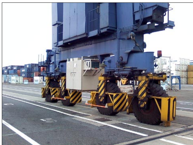
図6 ハイブリッド電源装置取付け Installation of hybrid system
