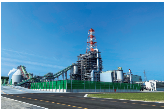
バイオマス発電プラント
