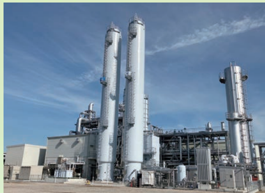
▲世界初のLAES商用実証プラント (中央部2本のタンクが液化空気貯蔵タンク)
