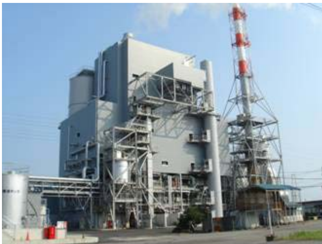
多様な燃料を活用し、エネルギー資源の有効活用とCO 2 排出削減に貢献するCFBボイラ
