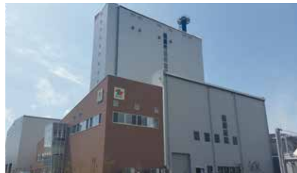
循環流動層 (CFB) ボイラ
