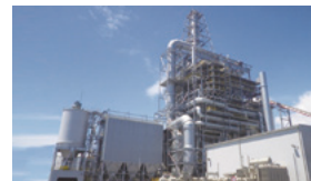
循環流動層(CFB)ボイラ
