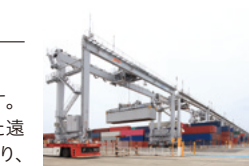
遠隔操作RTG
