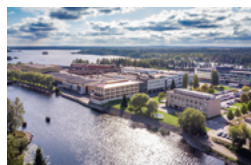
フィンランド ボイラ関連工場
