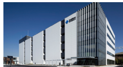
2025年4月に開所した 技術研究・開発棟 Cs'-Lab+
