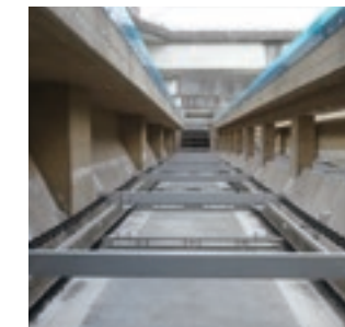
汚泥かき寄せ機
