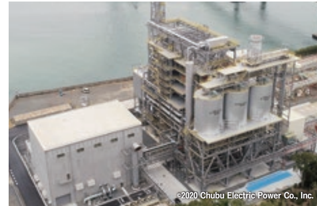
バイオマス発電プラント(中部電力(株))
