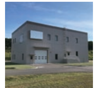
岩内・共和下水道管理センター 流量調整棟
