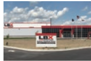
米国LBX社 カスタマーエクスペリエンスセンター
