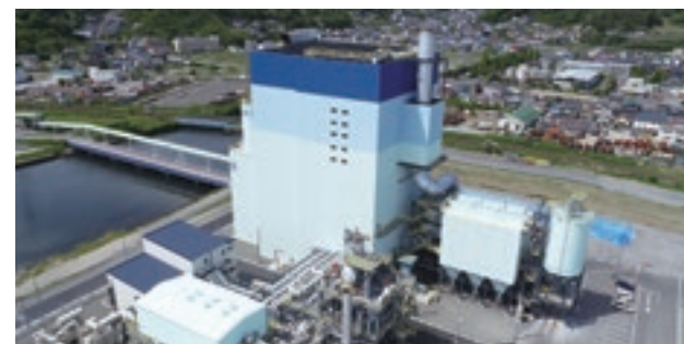
バイオマス発電プラント(ENEOSバイオマスパワー室蘭合同会社)
