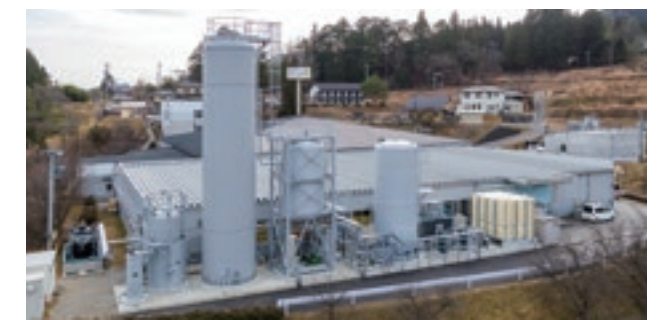
嫌気性排水処理設備
