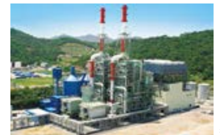
循環流動層(CFB) ボイラ
