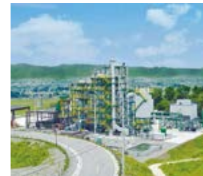
循環流動層(CFB) ボイラ
