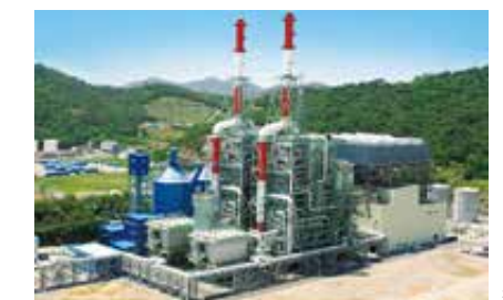
循環流動層(CFB)ボイラ
