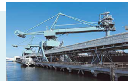
連続アンローダ(同形の既設機)
