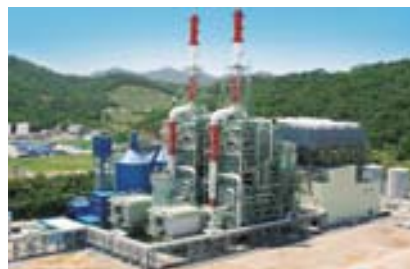
循環流動層(CFB)ボイラ
