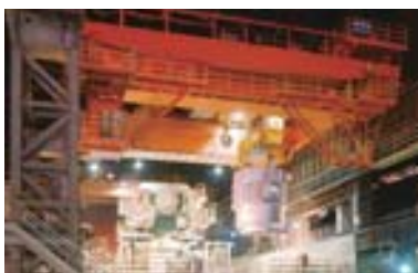
レールクレーン
