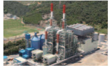
循環流動層(CFB)ボイラ
