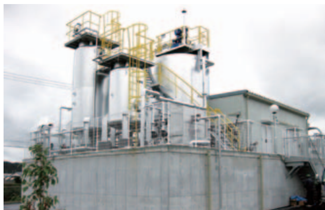
活性汚泥処理設備「スミスラッジ®システム」
