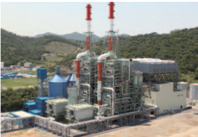
循環流動層(CFB)ボイラ
