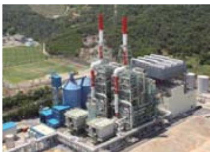
循環流動層(CFB)ボイラ
