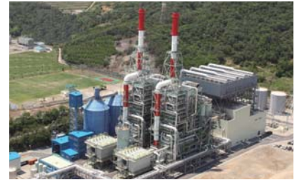
循環流動層(CFB)ボイラ
