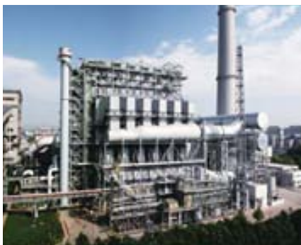
乾式脱硫・脱硝設備
