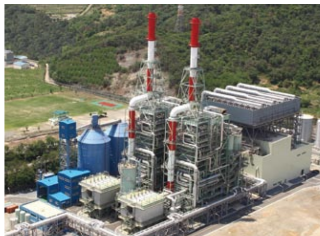
循環流動層(CFB)ボイラ
