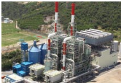
循環流動層(CFB)ボイラ
