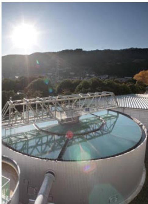
凝集沈殿槽「スミシクナー」
