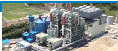
CFB（循環流動層）ボイラ
