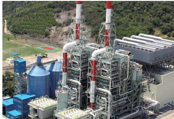
CFB(循環流動層)ボイラ
