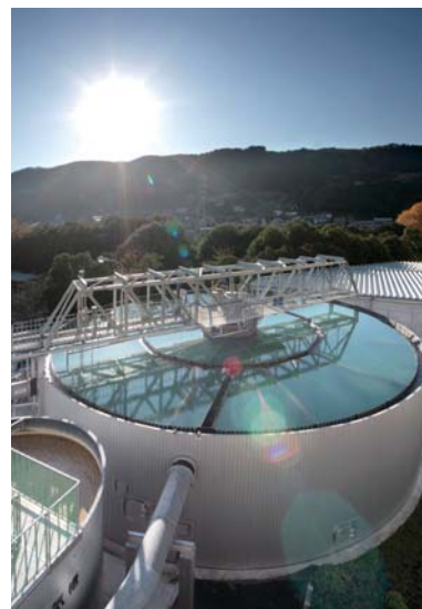
凝集沈殿槽「スミシクナー」
