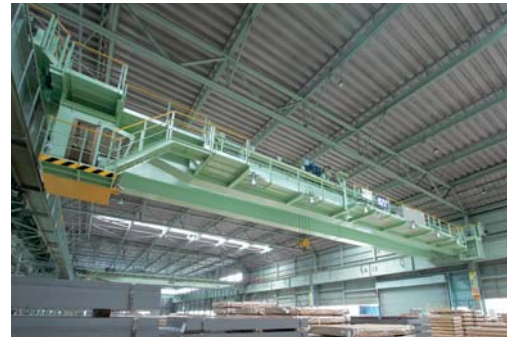
天井クレーン
