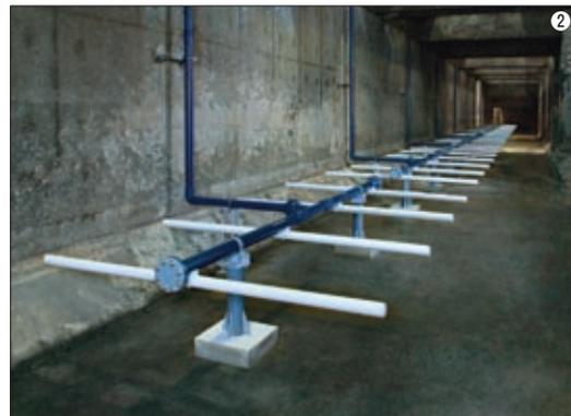
メンブレンパイプ式超微細気泡散気装置 ミクラス®
