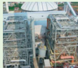
DSR/中国 能力：蒸発量毎時220t×3基
