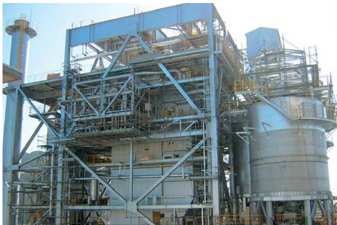
サミット明星パワー(株)向け大型バイオマス発電設備
