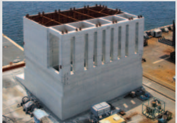
神奈川県三崎漁港ケーソン
