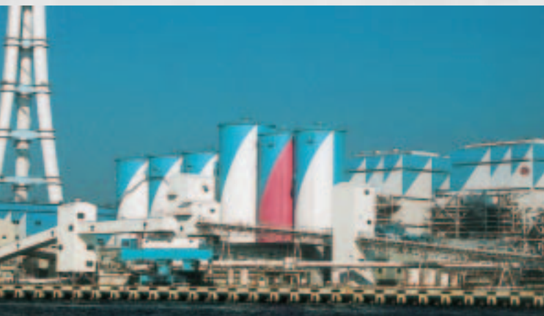
中部電力株式会社 碧南火力発電所4号機用灰処理装置及び副資材設備
