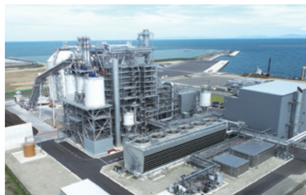
Biomass power plant (Kanda Biomass Energy K.K.)
