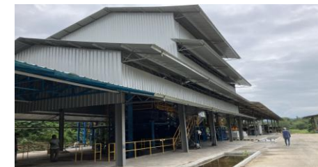
バイオ炭製造実証試験設備機 (製造能力2ton/日 135kW発電付)
