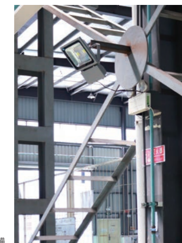
昆山工場照明設備
