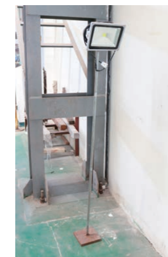
昆山工場照明設備
