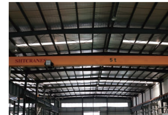
昆山工場天井
