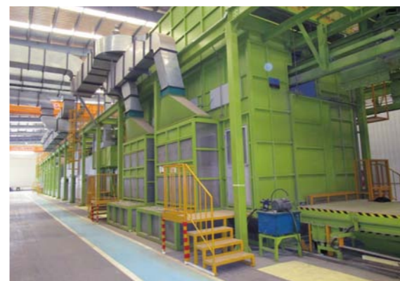
建機唐山の塗装工場
