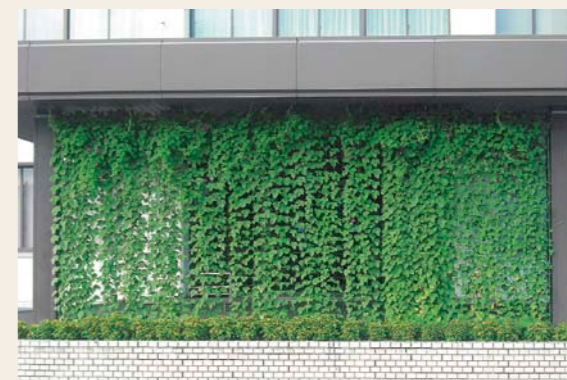
新居浜工場のグリーンカーテン
