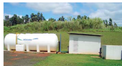
排水処理設備
