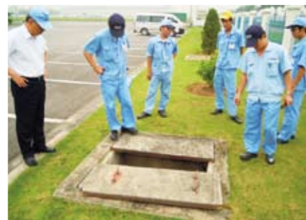
環境監査 ベトナム減速機工場での下水排水路の確認
