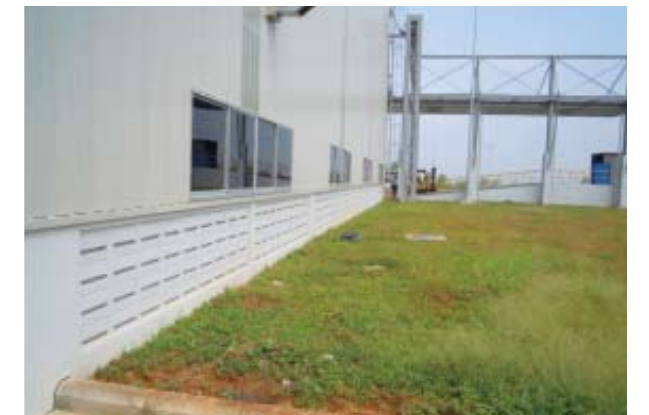
インドネシア建設機械工場 壁面通風孔
