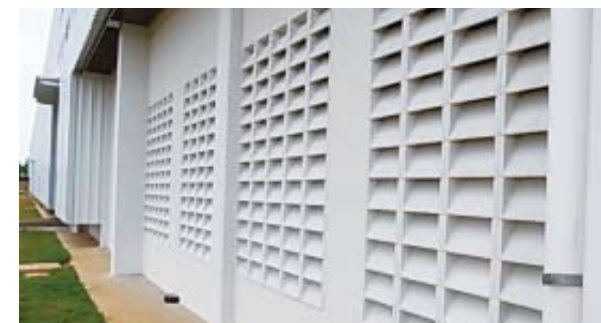
ブラジル減速機工場 壁面通風孔
