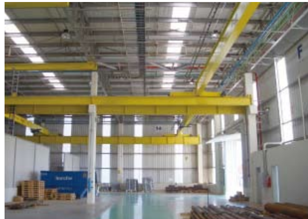
ブラジル減速機工場 天井、および壁面へ設置された明り取り窓により、日中は工場照明が必要ない。
