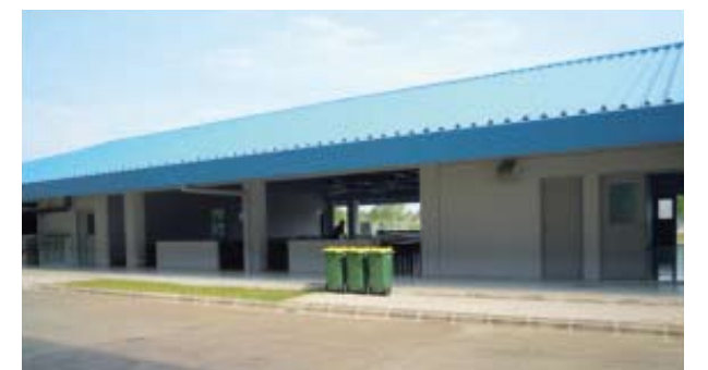
インドネシア建設機械工場 食堂の2面は開口構造となっている。
