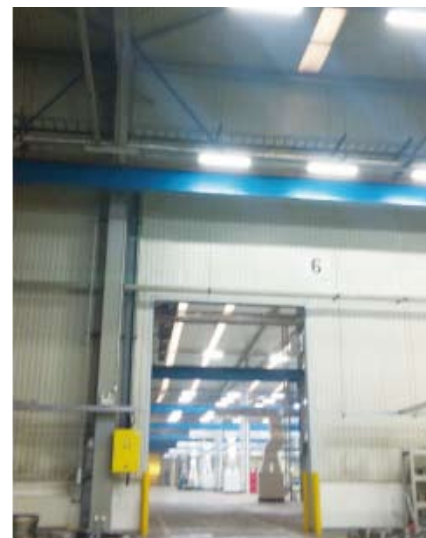
中国唐山減速機工場増設工場での天窓拡大 壁の向こう側が増設工場。 天窓が1列から2列に拡大している。
