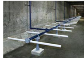
メンブレンパイプ式超微細気泡散気装置「ミクラス®」
