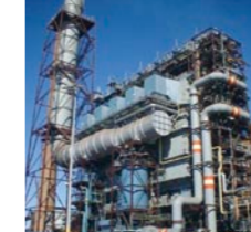
乾式脱硫脱硝装置
