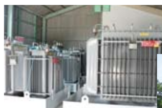
微量PCB含有変圧器の保管
