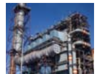
乾式脱硫脱硝装置
