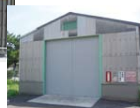
PCB保管倉庫外観
