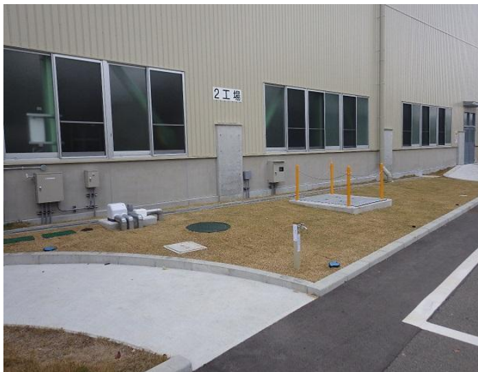
日本スピンドル（株） 雨水貯留槽（埋設）
