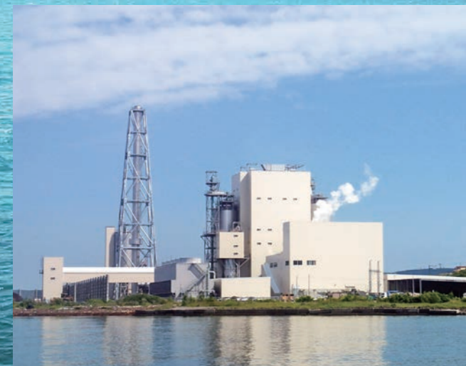
バイオマス発電プラント (サミット半田パワー (株) 納入)
