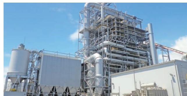
バイオマス発電プラント (紋別バイオマス発電(株)納入)
