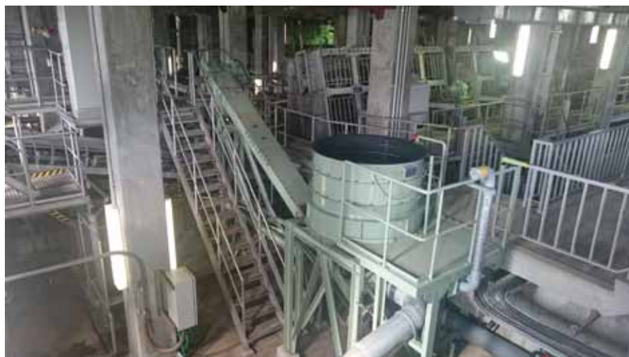
旋回流式沈砂分離機 Swirling flow grit separator
