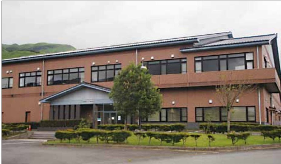
汚泥再生処理センター Sludge recycling center
