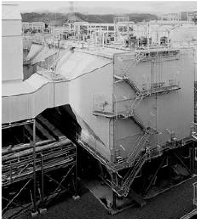
石炭火力用低低温電気集塵装置
