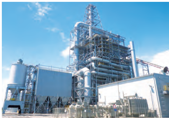
バイオマス発電設備
