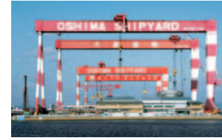
ゴライアスクレーン
