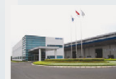
インドネシア 油圧ショベル工場
