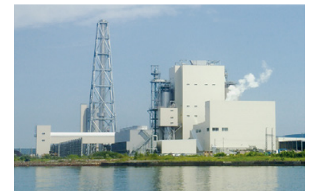
バイオマス発電プラント(紋別バイオマス発電(株)納入)
