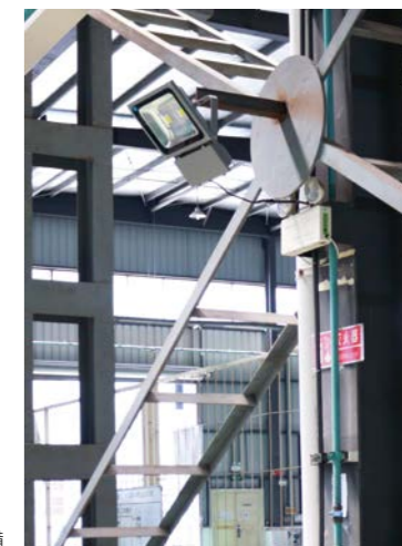
昆山工場照明設備
