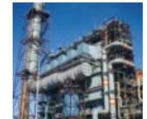
乾式脱硫脱硝装置
