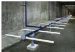
メンブレンバイフ式超微細気泡散気装置「ミクラス®」
